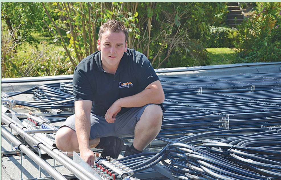
Firmenchef Sebastian Wallenfang bei der Installation einer Solarthermie (Luftabsorber) für Eisspeicher/Wärmepumpe.
